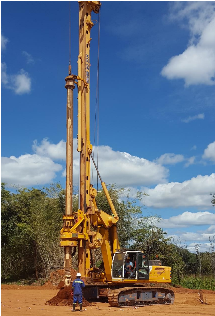
Figure 14 : Forage du puits pilote pour le puits de ventilation 2.
