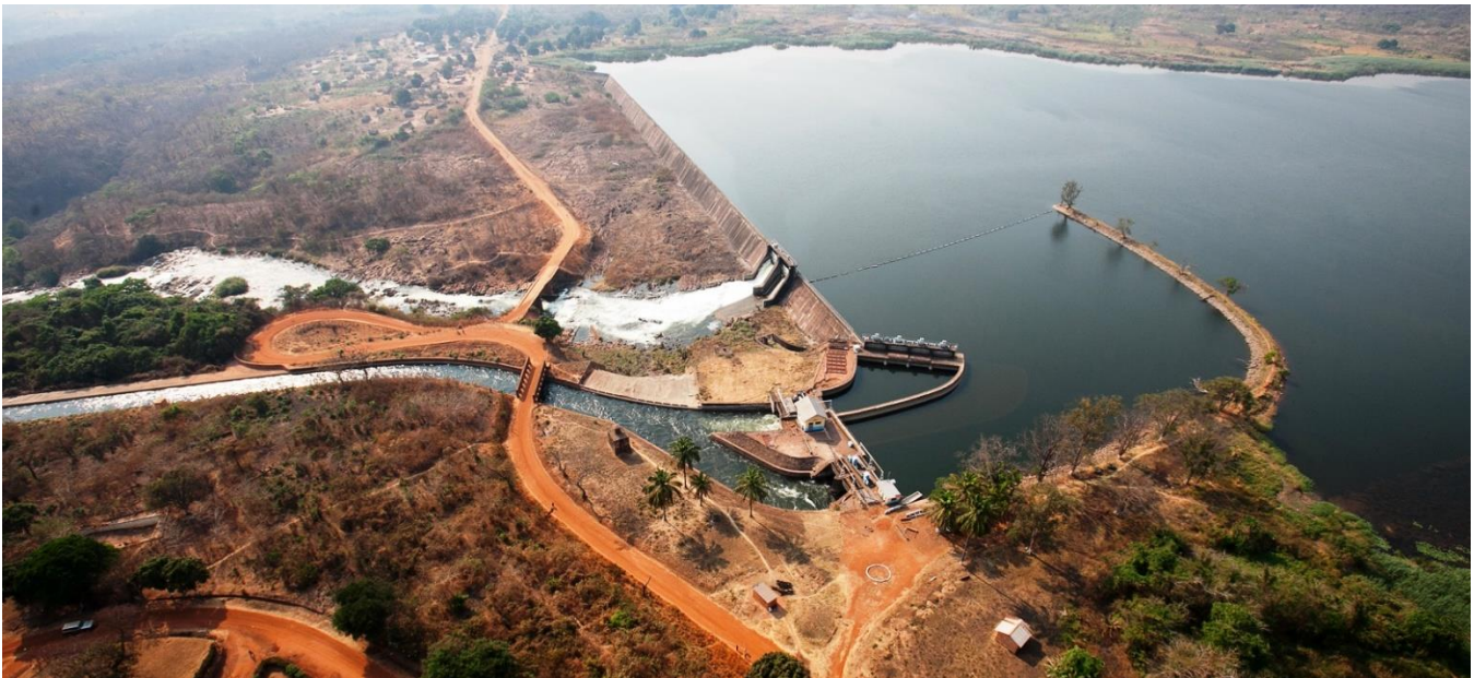
Figure 18 : Modernisation du barrage hydroélectrique de Mwadingusha.
